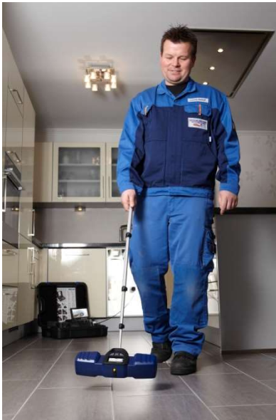
Afb. 7: Lokalisatie van de camerakop in de vloer
