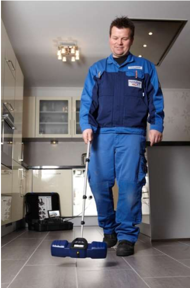
Abb. 7: Lokalisierung des Kamerakopfes im Boden
